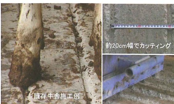
図3 フロントローダーに取り付けた歯で目地切りした事例
