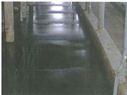
図4 通路用マットの施工例
