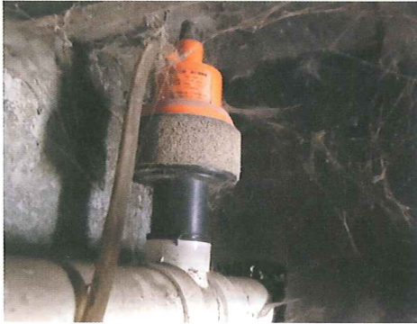
写真1 清掃されていない調圧器
