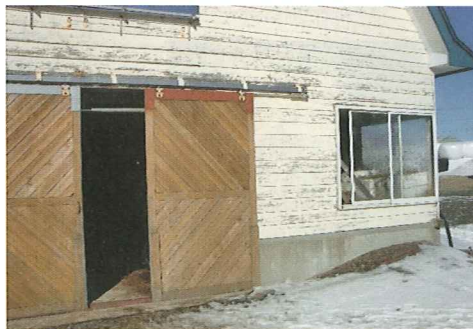
写真3 天気の良い日中は南側の扉・窓を開放
