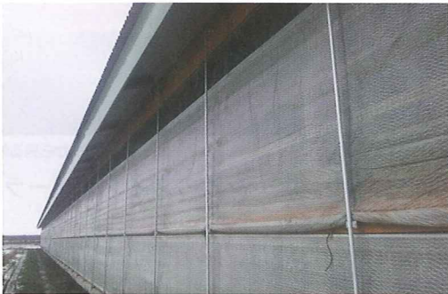
写真2 壁面のカーテンを開けて入気 (カーテンの上側を開けることで牛に直接風が当たらない)
