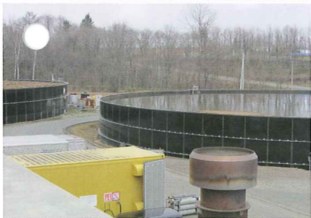
消化液貯留槽
