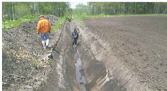
写真1 新設した明渠
