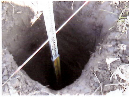
写真2 ③縦孔暗きよの施工
