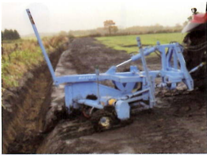
写真1 ①明きよと②カットソイラーの施工
