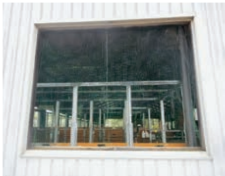
写真3 窓枠を外して換気
