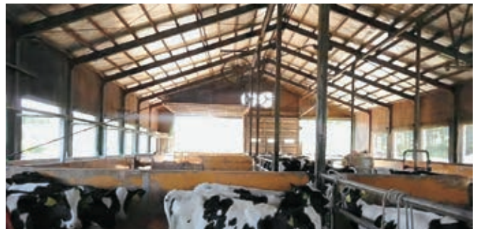
写真2 窓・扉を全開にして換気を行う牛舎
