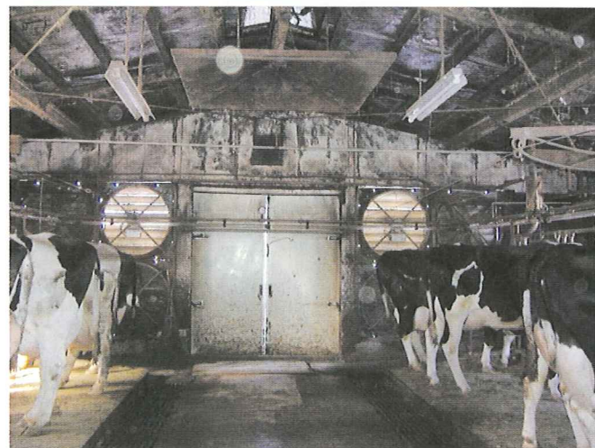
図3 トンネル換気による換気
