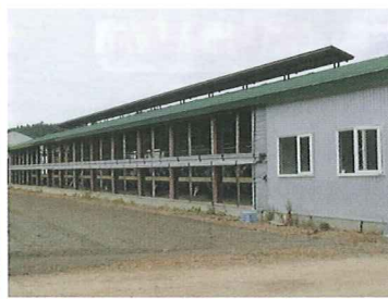
写真2 開口部を最大限にして換気量を確保しましょう
