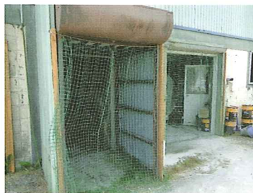
写真3 入気側を大きく解放した事例(防鳥ネットも設置)
