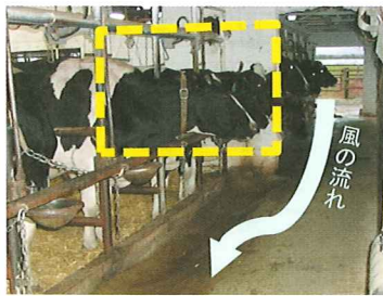
写真4 風の流れをさえぎる壁(黄色の点線部)は、建物の強度を保てる範囲でできるだけ解放する
