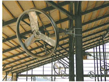
写真1 湿度で熱さを感じ始める6月始めには、連続的に換気扇を回して暑熱ストレスをためないようにする
