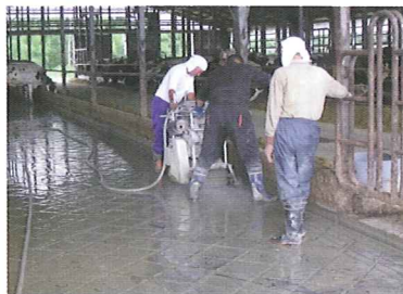
写真2 既存のダイヤモンド目地に専用機でストレート目地を施行する様子
