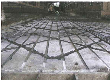
写真3 右写真の施行後の状況
