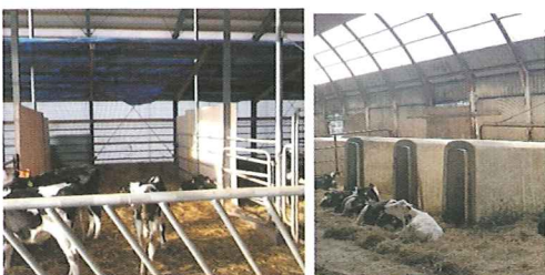
左: 中天井をつけて仕切りにコンパネを設置、保温性を高める 右: ハッチを設置して、寒い時に自由に入れるようにする
