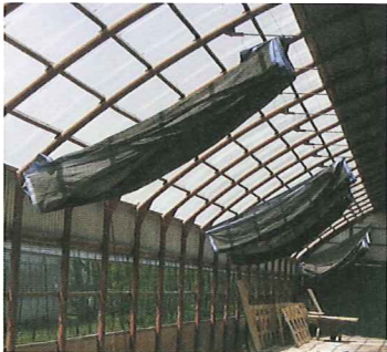
写真2 寒冷紗で採光量を調節できるほ育舎
