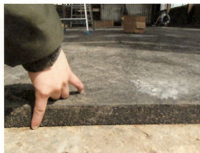
写真 底冷え対策でマットを敷設
